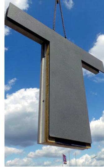
Betonsandwich-Elemente sind mehrschichtige, vorgefertigte Fassadenplatten, die aus einer Trag-, Wärmedämm- und Vorsatzschicht bestehen. Anders als bei vorgehängten Fassadenelementen, die nachträglich angebracht werden müssen, wird die Vorsatzschale hier gleich mitproduziert. Ein Element mit beispielsweise einer 14 Zentimeter dicken Innenschale, einer Zehn-Zentimeter-Dämmung und einer sechs Zentimeter dicken Vorsatzschale kann einen U-Wert von  $0,27 \text{ W/m}^2\text{K}$  problemlos erreichen.
