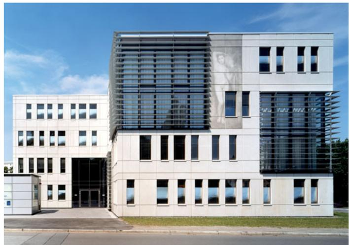
*Eastsite I: Medien- und Kommunikationszentrum mit einer Fotobeton-Fassade.*
